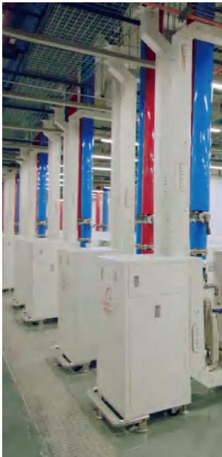
两相浸没式液。数据中心浸没式液冷技术的能耗主要来源于促使液体循环的泵和室外冷却设备。由于浸没式液冷的室外侧通常是高温水，其室外冷却设备往往可以利用自然冷源且不受选址区域的限制，从而起到节能减排的目的。
